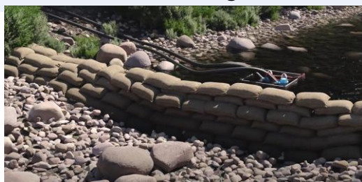
Início da obra
