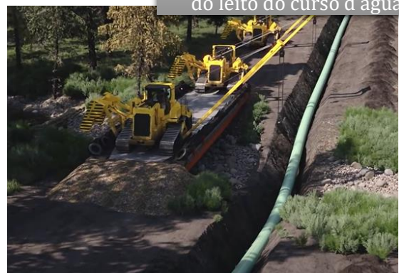
Foto 02: Tubulação soldada externamente e depois inserida na vala.
