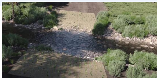
Final da obra
