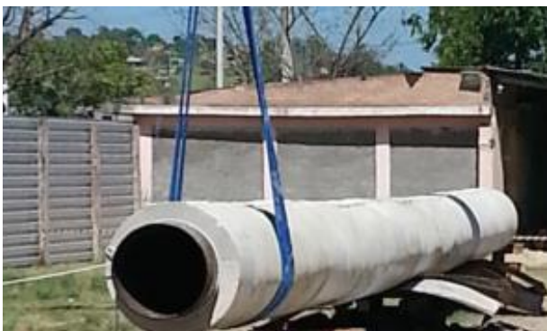
Foto 01: Jaqueta de concreto para receber a tubulação.
